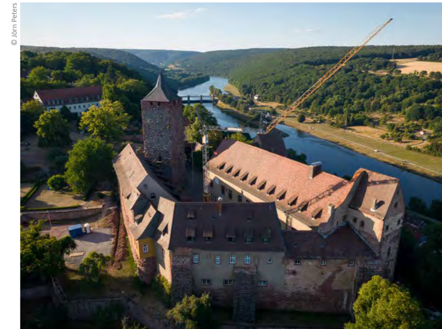
Bis 2024 wird ein Baukran Innenhof und Panorama der Burg prägen.
